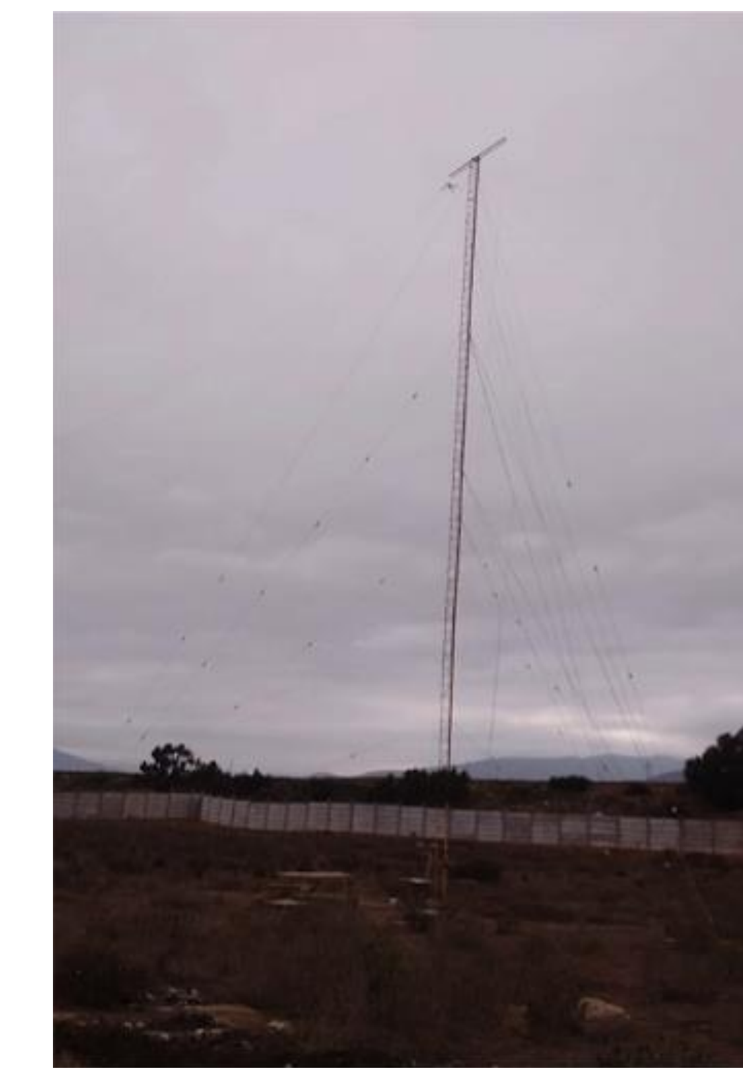
Figura: Antena delta doble usada por la ionosonda IPS-42 en La Serena, Chile.
