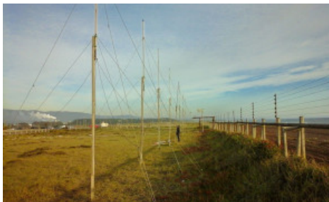
Radares HF instalados.
