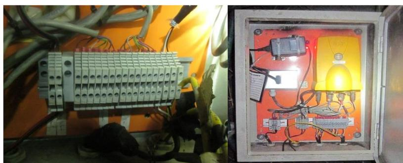
**Figura 5.57.** A la derecha se observa la caja metálica instalada en la pared sur del Socavón Norte- que contiene entre el interruptor, conexión a red eléctrica y transformador, la unidad QS4 (caja “amarilla”). Debajo de esta unidad se encuentra la matriz que conecta cada cable que proviene de 2 sensores a los dos conectores SEISMIC 1 (derecha en QS, color rojo) y SEISMIC 2 (izquierda en QS, color azul).
