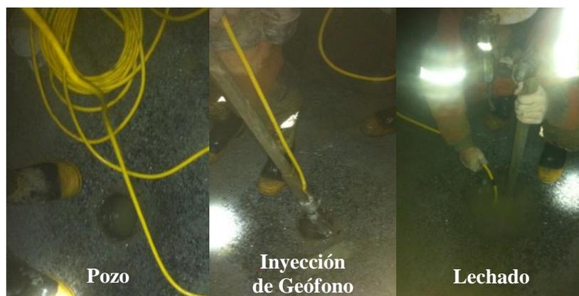
**Figura 5.54.** Se ilustra el pozo vertical descendente, y parte del proceso de instalación. El desarrollo de instalación es análogo al de un geófono vertical ascendente.
