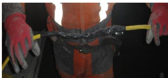
**Figura 5.49.** Mufa que se genera para la extensión de los geófonos que se instalarán a una altura mayor de 10 [m].
