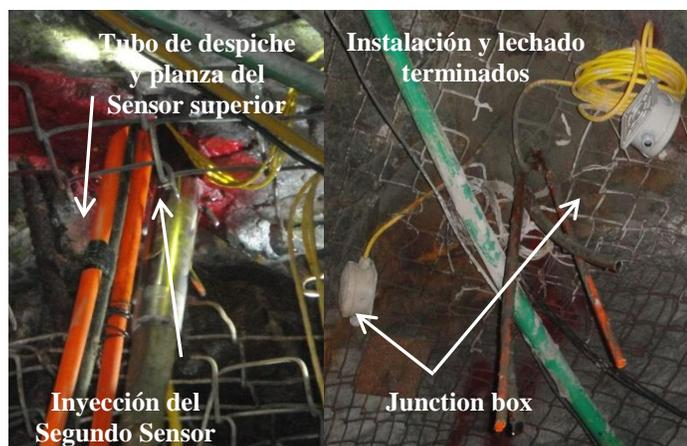
**Figura 5.56.** La imagen de la izquierda ilustra el proceso de la inyección del segundo sensor el cual es instalado en la parte inferior del pozo. La imagen de la derecha muestra el proceso terminado, previo al sellado de los tubos para evitar la caída de cemento y para su posterior secado.
